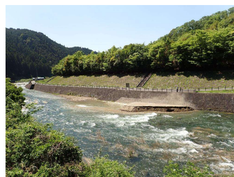
比奈知ダム下流での土砂還元状況
