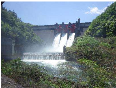
室生ダムフラッシュ放流実施状況
