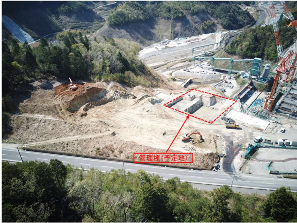
管理棟敷地の掘削状況
