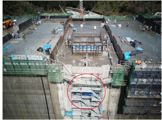
常用洪水吐設備の設置完了
